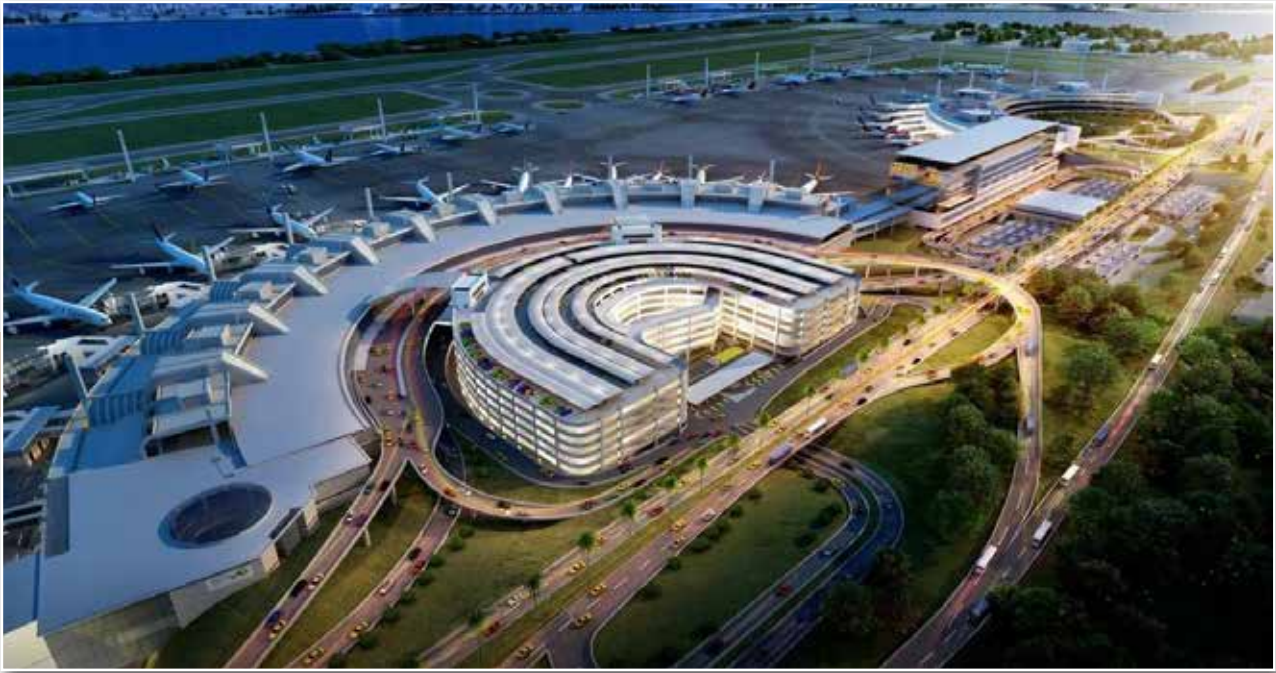
Rio de Janeiro's Galeão International Airport
